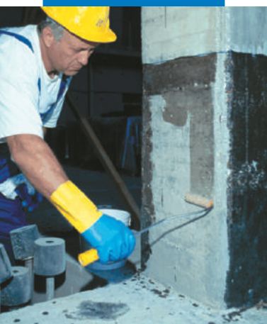
Aplicación de la 1ª mano de MapeWrap Primer 1
