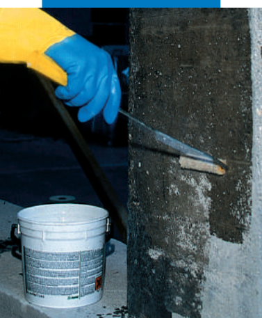
Aplicación de la 2ª mano de MapeWrap Primer 1
