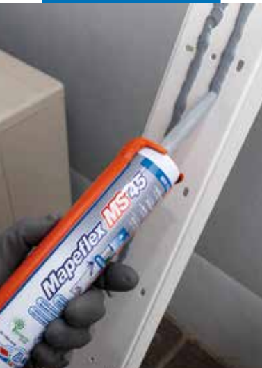
Encolado de perfiles de plástico en exteriores
