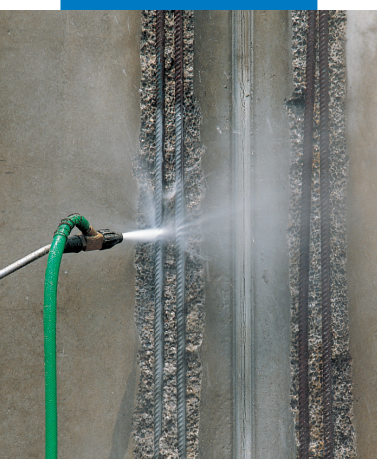
Limpieza de las varillas de refuerzo
