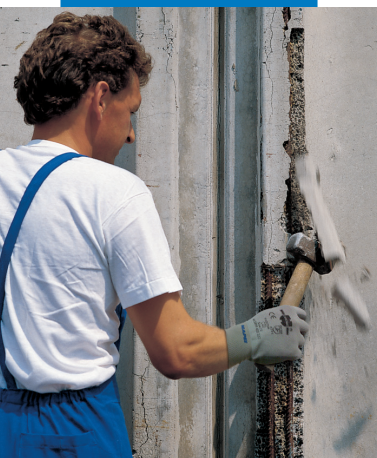
Demolición del concreto degradado o deteriorado
