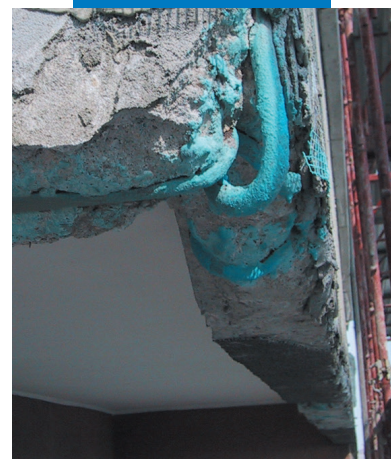
Varillas de acero en la cara frontal de la viga en un balcón tratadas con Mapefer 1K
