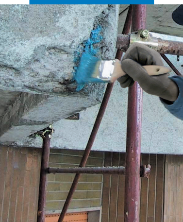
Aplicación de Mapefer 1K con brocha sobre las varillas de refuerzo en balcón de concreto
